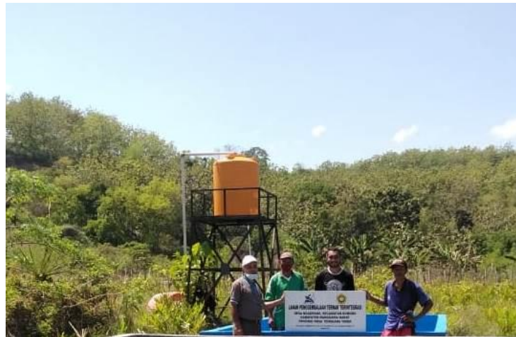
Gambar 4. Bak penampungan air
