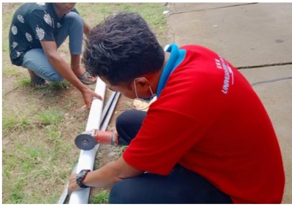
Gambar 1. Proses Pemotongan Paralon
