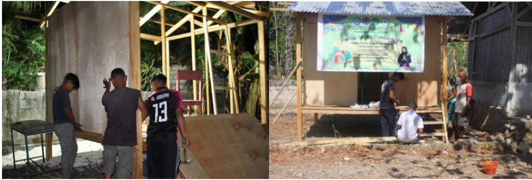
Gambar 4. Pembangunan Balkon Pintar Kreatif
