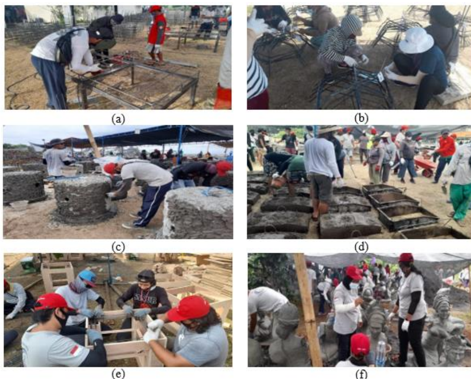
Gambar 1. Pembuatan Struktur Kebun Karang oleh Pekerja: (a) Rak Meja; (b) Heksagonal; (c) Fishdome; (d) Roti Buaya; (e) Rumah Batako; dan (f) Patung
