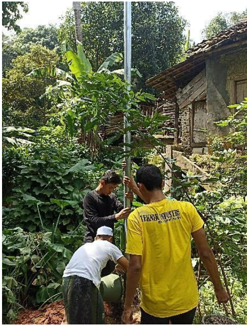
Gambar 1. Pemasangan Tiang Lampu
