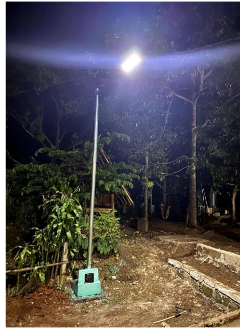
Gambar 2. Pemasangan Tiang Panel
