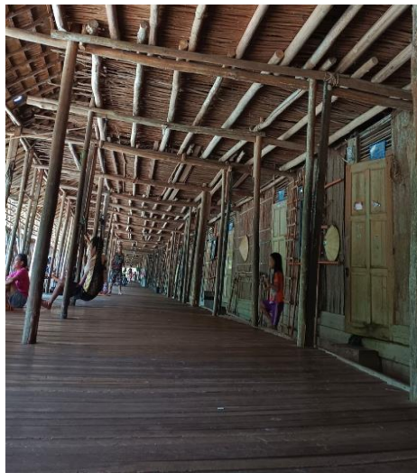
Gambar 1. Kayu Belian sebagai Penyanggah Rumah Betang
