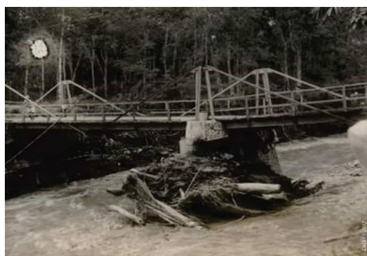
Gambar 10. Keadaan Jembatan Kudung tahun 1939 setelah diterjang banjir
