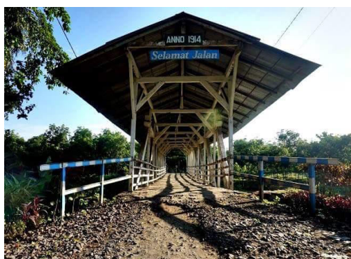
Gambar 09. Jembatan Kudung Kendenglembu
