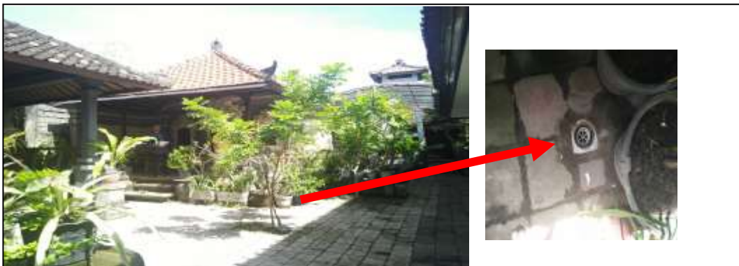
Gambar 03 Lubang Sumur Resapan (Jalan Setra Ganda Mayu, Tanjung Benoa)
