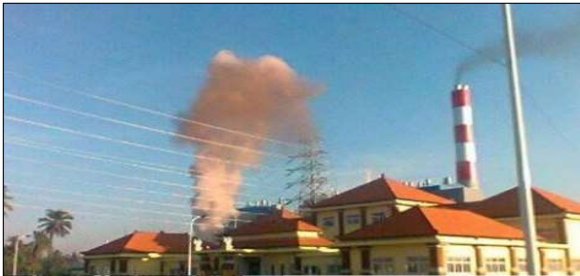
Gambar 2 Cerobong Asap Pembangkit Listrik Tenaga Uap (PLTU) Celukanbawang (Sumber: Abd. Razaq, 2018)
