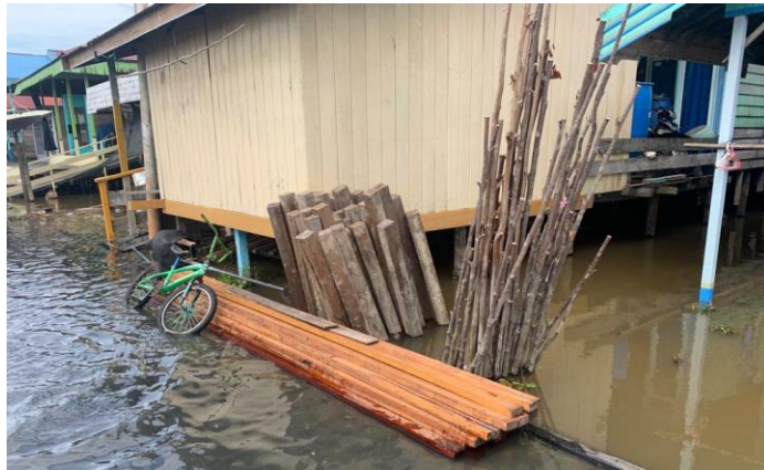
Gambar 7. Kayu Untuk Pembangunan Sekat Tambahan
