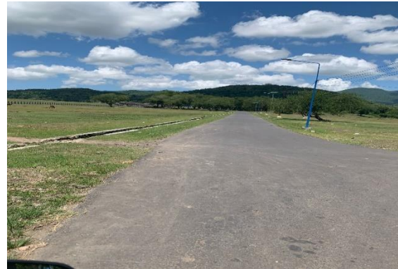
Gambar 3. Akses Jalan Bendungan Pengga
