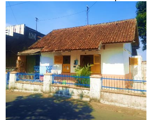
Gambar 3. Rumah Kwarasan Tipe Kecil Perumahan Hindia-Belanda "Kwarasan" sebagai cagar budaya tentu
