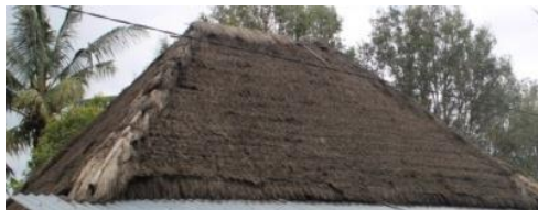
Gambar 7. Atap menggunakan genteng tiing (a) dan ilalang (b) (Sumber: Dokumen Pribadi, 2020)
