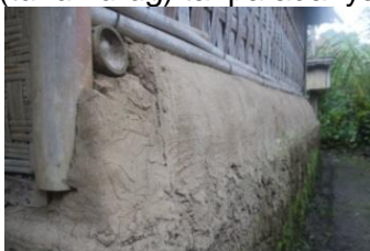
Gambar 4. Kaki bangunan rumah adat dengan tanah polpolan (Sumber: Dokumen Pribadi, 2020)
