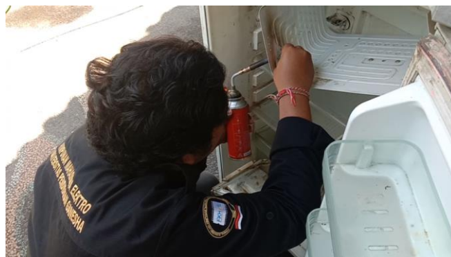
Gambar 1. Gambar Video Perbaikan Evaporator Bocor
