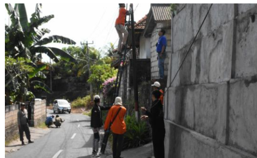
Gambar 4. Penarikan Fiber Optic dari ODP
