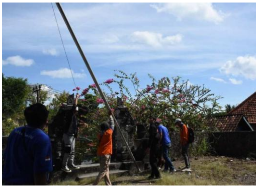
Gambar 5. Pemasangan tiang jalur fiber optic
