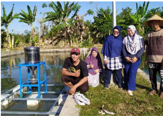
Gambar 7. Proses Instalasi mesin oleh Tim
