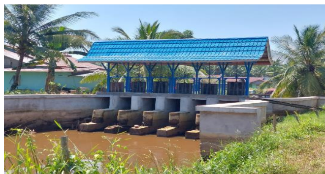
Gambar 10. Tanggul Sungai untuk Mencegah Air Pasang/Banjir Masuk ke Desa Sungai Kupah
