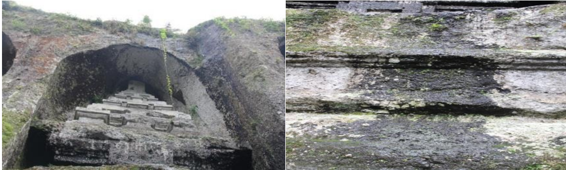
Gambar 2. Kerusakan Mekanis dan Fisis pada Kompleks Candi Lima pada Candi Tebing Gunung Kawi sebagai Tahap Pendefinisian
