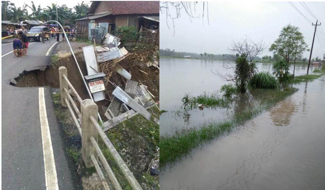
Gambar 4. a) Jembatan Sungai Jatinegara ambrol di Desa Mergosono, Kecamatan Buayan; b) Lahan pertanian dan jalan tergenang banjir di Kecamatan Adimulyo (Sumber: Dokumentasi Lapangan, 2017)
